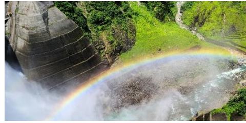
黒部ダム第4発電所 放水時にかかる虹
